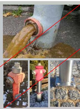
Der Hydrant mit Sickerstein / Umhüllung mit anstehendem Restwasser steht im Kontakt mit dem Trinkwassernetz.
